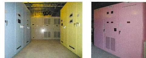
電気室 ※カラーユニバーサルデザインに沿って、見学者・運用者が分かりやすい設計をしています。
